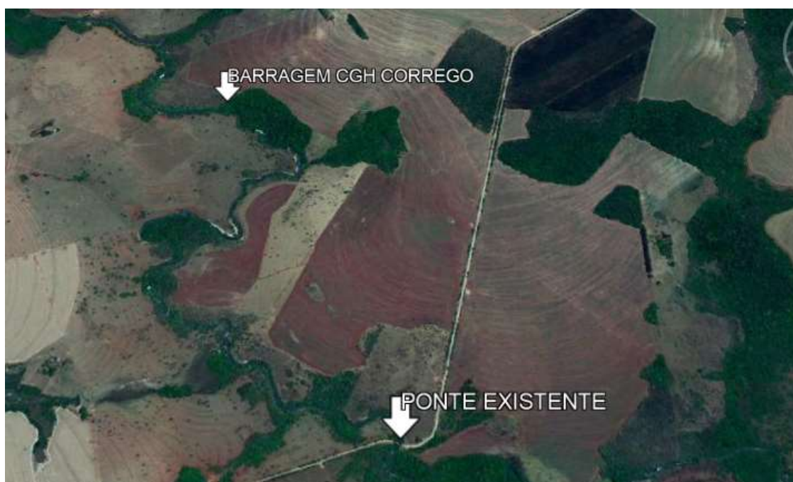
Figura 01 - Área de influência a jusante da barragem – a ponte municipal fica distante 3,50 km da Barragem da CGH Córrego
